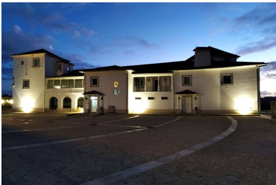
Fig. 13 – Edifício sede do Conservatório de Música de Águeda (“Casa do Adro”).
